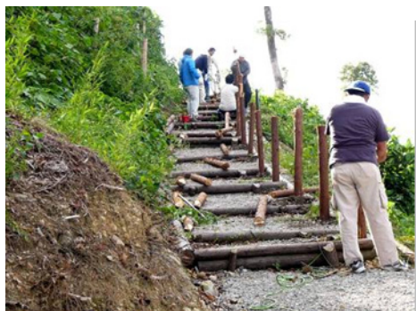
手すり取り付けの様子
