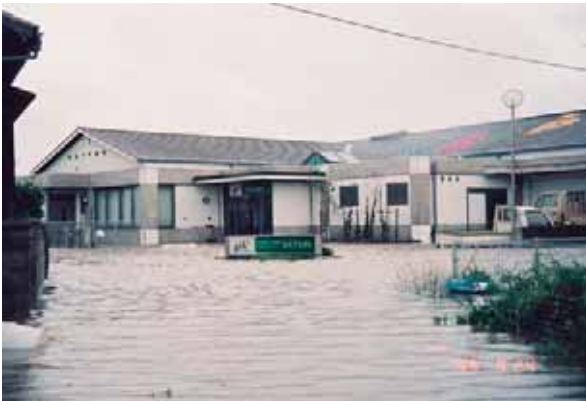
浸水は施設の屋根を覆うまでに及んだ
