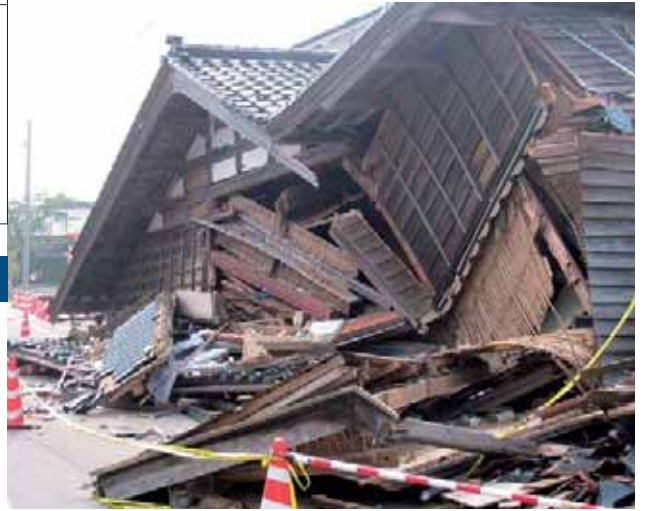
倒壊した家屋（諸岡地区）
