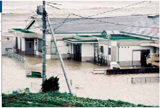
台風被害で浸水した「セルプときわ」
